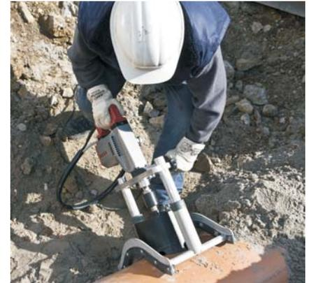
Forage de raccordement dans tuyaux de canalisation en PVC/béton - avec support de forage
