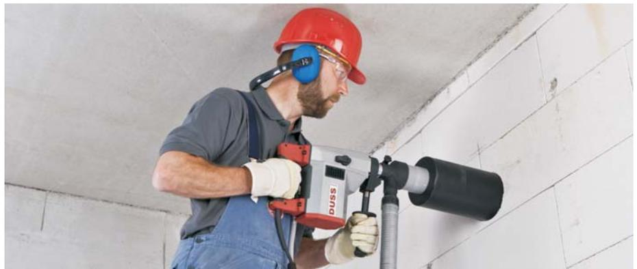
Forage à sec dans maçonnerie avec aspiration des poussières
