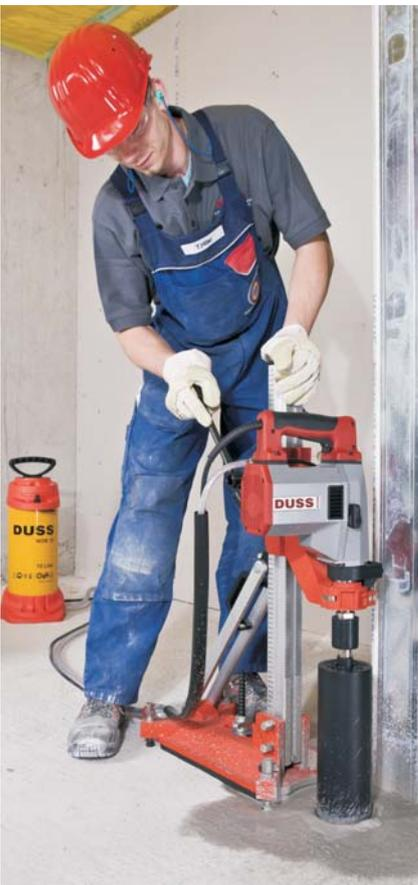
Forage à eau dans béton - avec colonne ou à main levée
